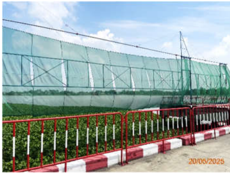
ภาพที่ 2.2-12 แนวสแลนส์ด้านข้างท่าเทียบเรือ J1A และระบบสเปรย์น้ำ
