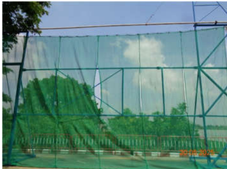
ภาพที่ 2.2-10 แนวสแลนส์ตามแนวรั้วด้านทิศตะวันตก และระบบสเปรย์น้ำ
