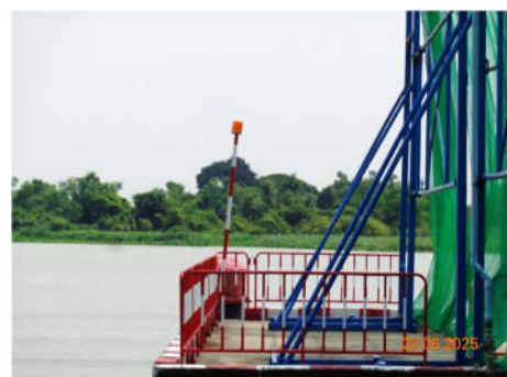
ภาพที่ 2.2-28 ไฟสัญญาณแสดงตำแหน่ง โครงสร้างท่าเทียบเรือ
