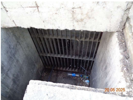
ภาพที่ 2.2-38 ตะแกรงดักขยะ
