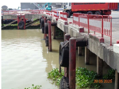
ภาพที่ 2.2-51 หลักกันเรือกระแทก
